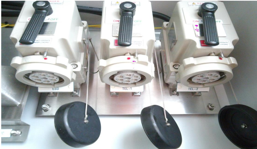
Slika 20: konektori ESD-a Hoegh Giant
