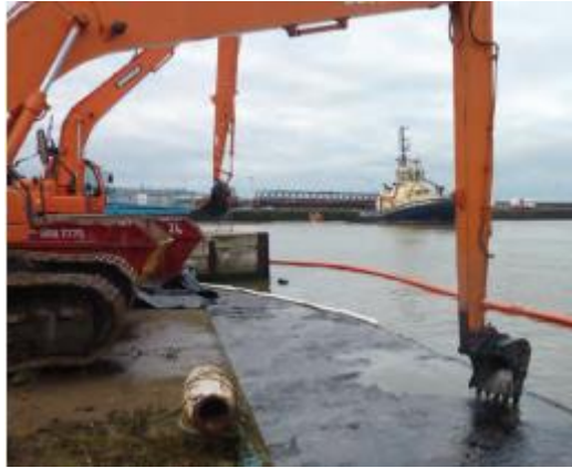
Slika 18. Proces prikupljanja ulja s obale pomoću bagera
