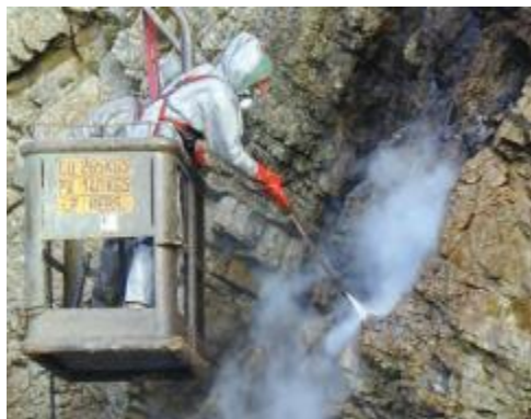
Slika 20. Pranje uljnih površina visokotlačnim sustavom
