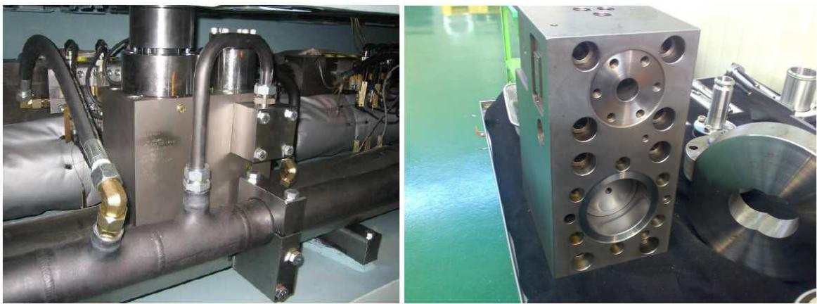
Slika 28. Ugrađena VCU jedinica i njene spojnice <sup>[2]</sup>
