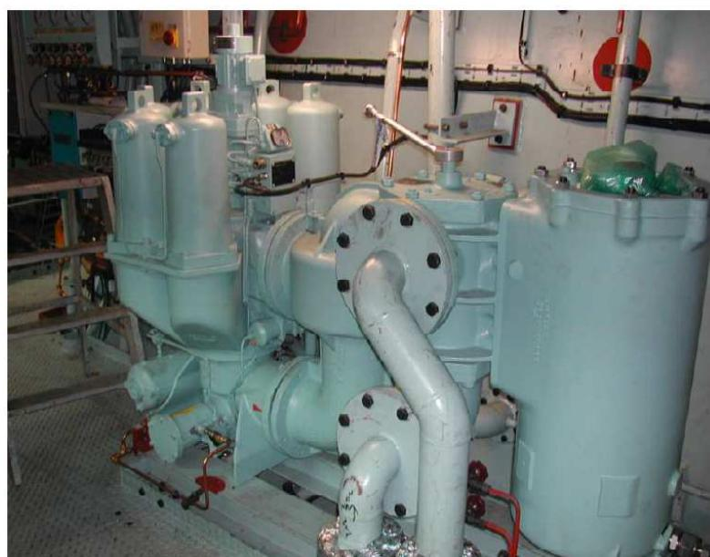
Slika 31. Automatski filter sistemskog ulja prije usisa kontrolnih i servo pumpi [2]
