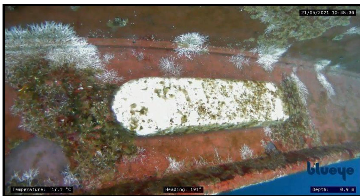
Slika 21. Žrtvena anoda na ljuljnoj kobilici
