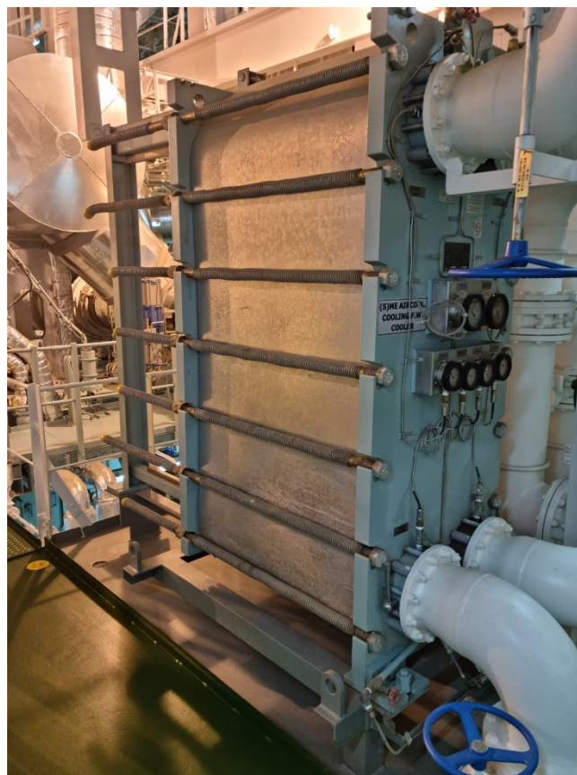
Slika 6. Rashladnik zraka odvojen od glavnog motora [7]
