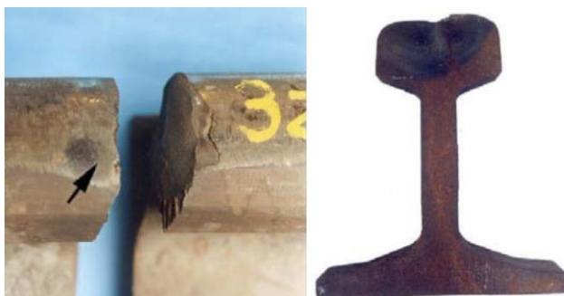
Slika 8. Jedan od sukcesivnih šinskih lomova u Hatfield –u usled zamora šinskog čelika (Office of rail regulation, 2006)
