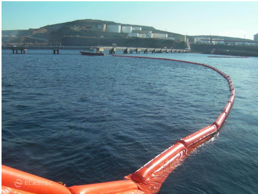
Slika 10. Postavljanje zavjesne brane, [22]
