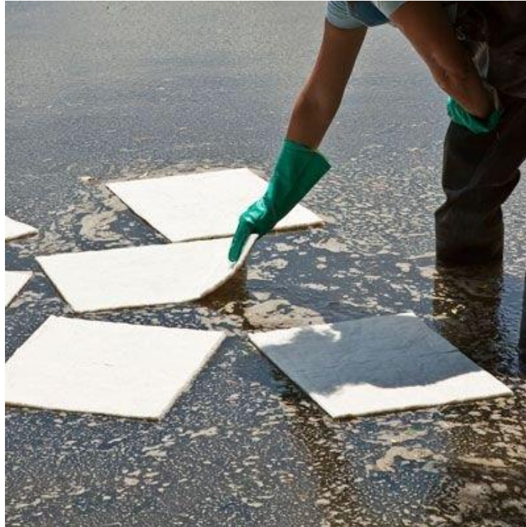
Slika 7. Postavljanje upijača na uljni izljev, [6]
