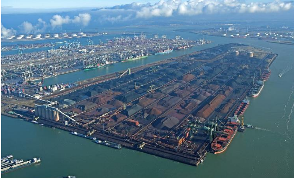
Slika 10. Slagalište za rasute terete
