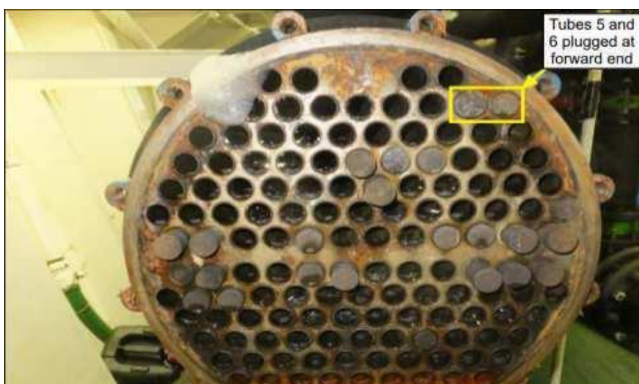
Slika 13: Prednji kraj desnog evaporatora
