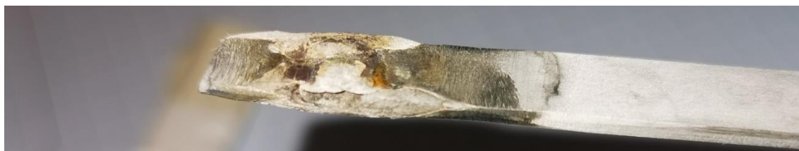
Slika 12. Korozija zavara koji nije pasiviziran
