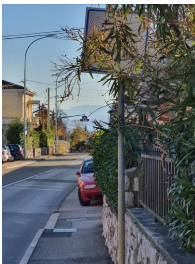
Slika 22. Vertikalna signalizacija C03
