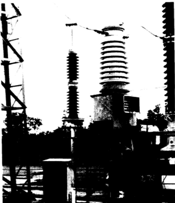
**Slika 15-Visokonaponska sonda u uporabi na trafostanici 110kV**
