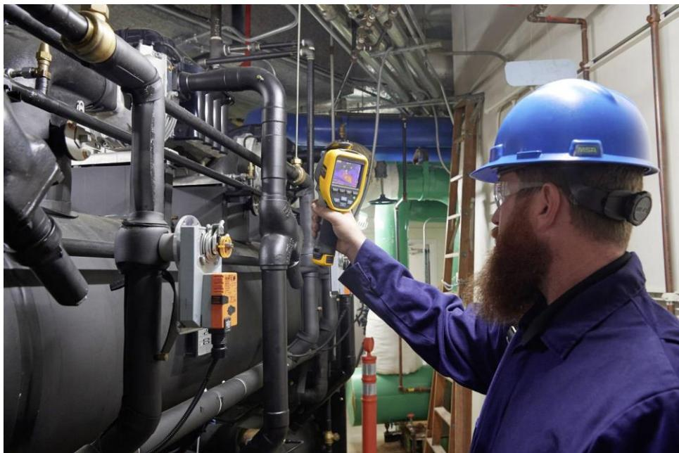
**Slika 22-Primjer nadzora sustava termovizijskom kamerom**
