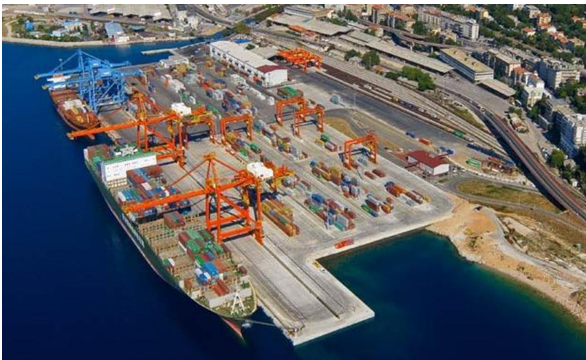
Slika 31. Kontejnerski terminal Vrata Jadrana, Rijeka
