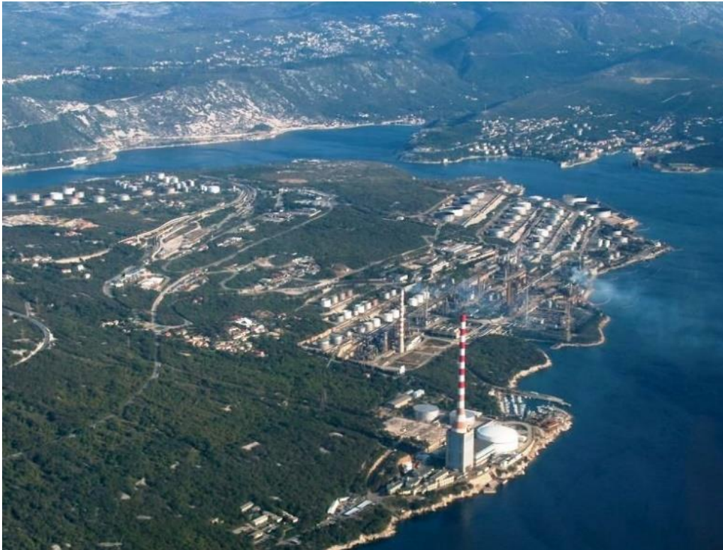
Slika 2. Rafinerija nafte Rijeka - Postrojenja Urinj [17]
