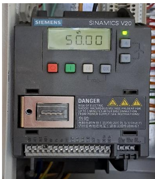
Slika 26: Vrtnja motora pri punoj frekvenciji
