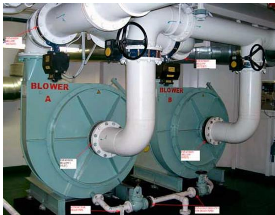
Slika 5. Puhala inertnog plina
