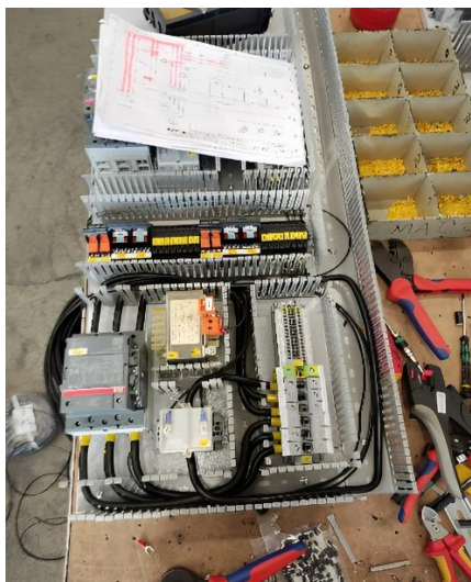
Slika 30. Proces ožičenja i postavljanja žica u plastične vodilice.
