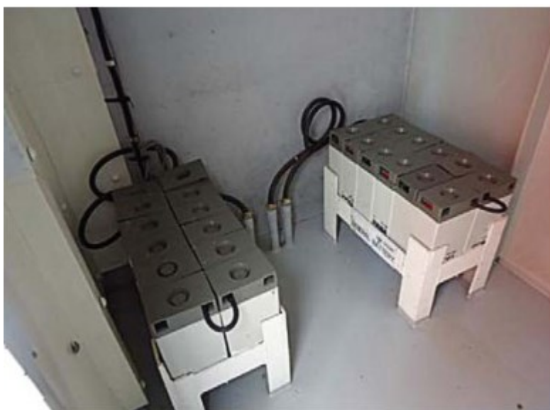
Slika 13. Primjer baterijske stanice na brodu
