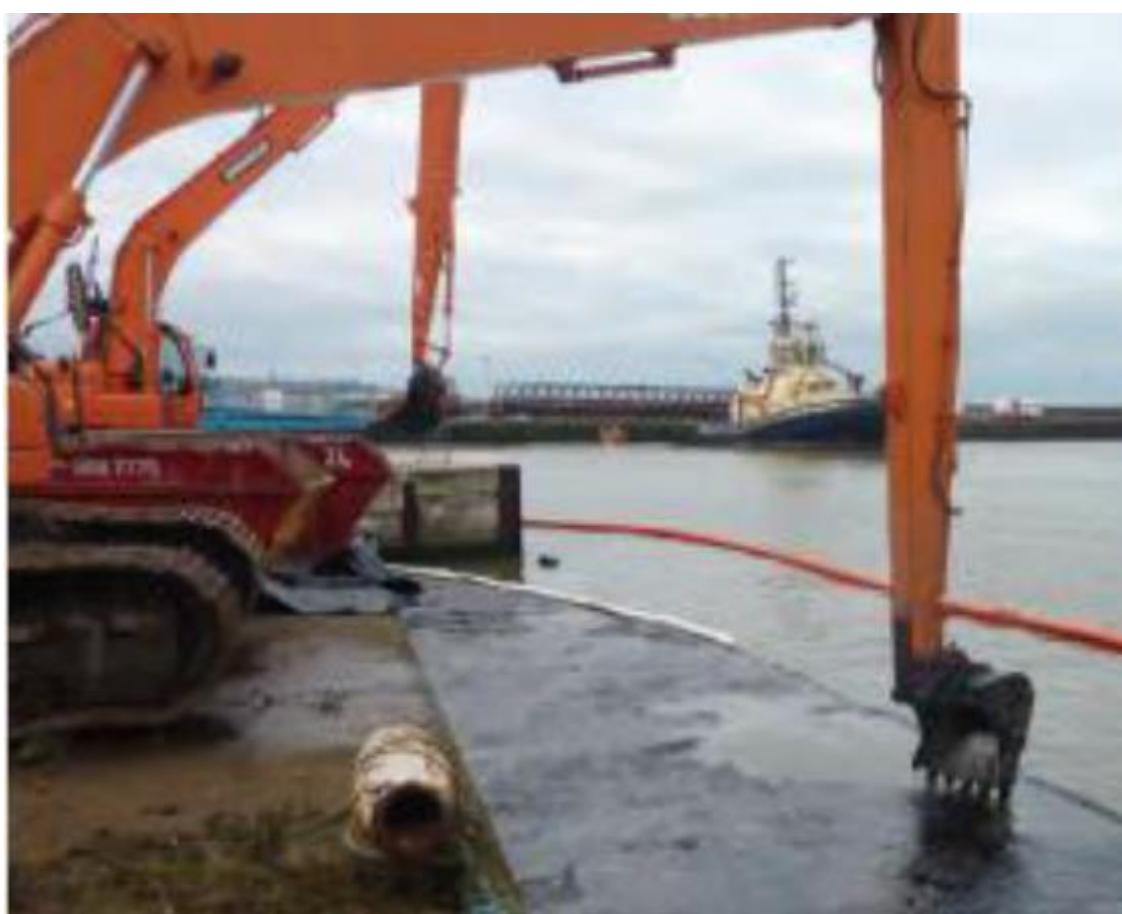
Slika 9. Prikaz uklanjanja ulja korištenjem bagera
