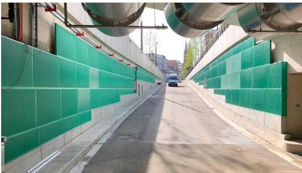
**Slika 26. Ulazak u tunel s apsorbirajućim panelima**
