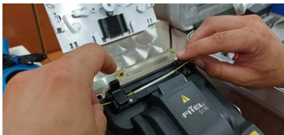
Slika 8. Priprema niti za postavljanje zaštite
