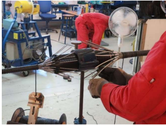
Slika 39. Dio postupka univerzalnog spoja
