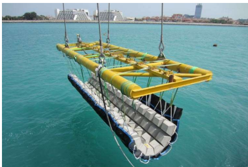
Slika 17. Podmorski madrac. Koristi se kada se podvodni kabele križaju
