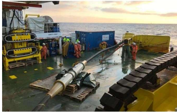
Slika 26. Popravak oštećenog podvodnog kabela koji spaja Maltu i Siciliju
