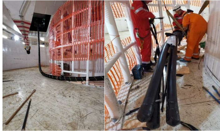
Slika 10. Uvlačenje kabela u vrtuljak te fiksiranje u središte
