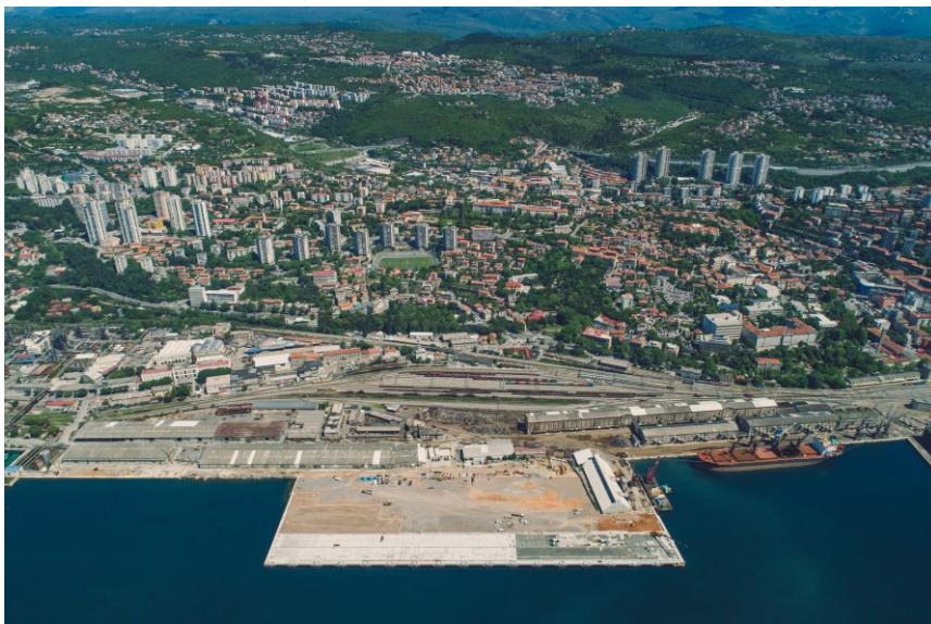
Slika 5 Završetak radova 1.faze izgradnje Zagreb Deep Sea terminala (2019.godina)
