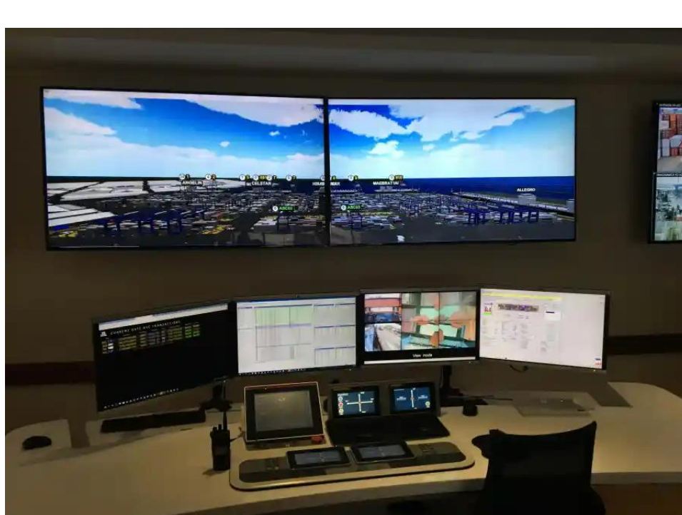
Slika 1. Kontrolna stanica za upravljanje ASC dizalicama
