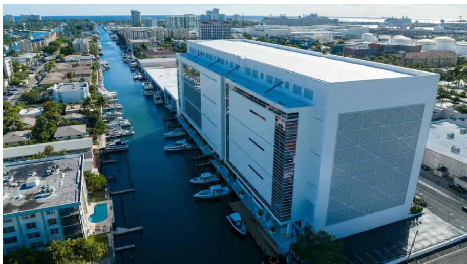
Slika 15 Zgrada F3 marine u Fort Lauderdale-u za regalno skladištenje plovila.
