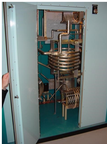
Slika 32. Vodič izrađen od šupljih cijevi
