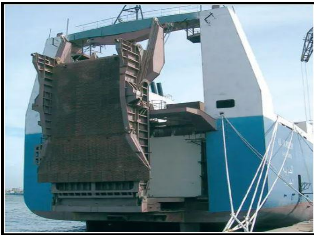
Slika 12 Krmena oktretana rampa
