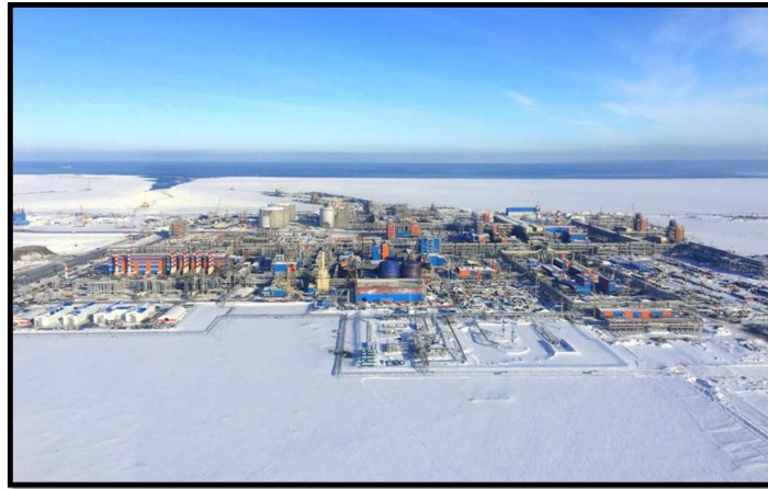
Slika 18. Postrojenje Yamal LNG
