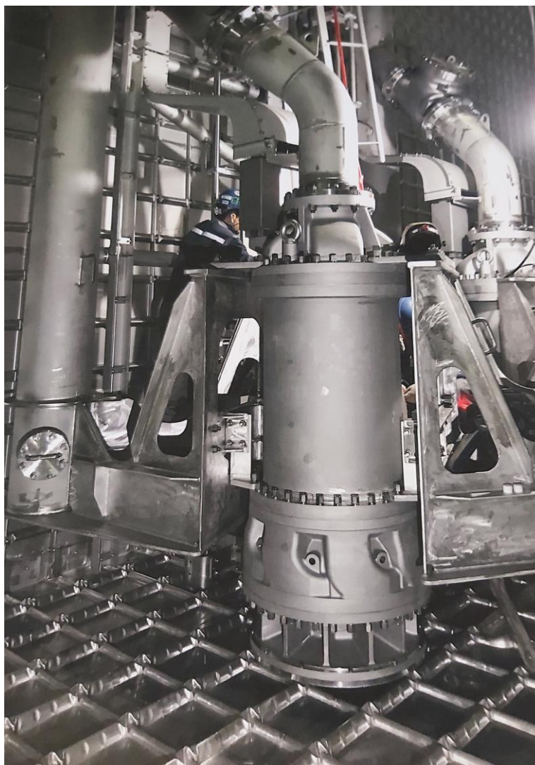
Slika 13 Remontno održavanje pumpi tereta na LNG brodu
