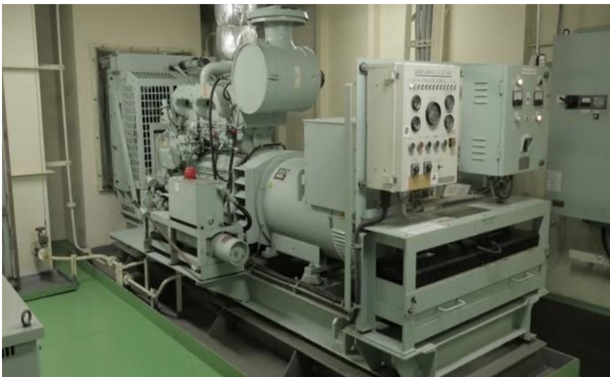
Slika 6. Prikaz generatora za nuždu
