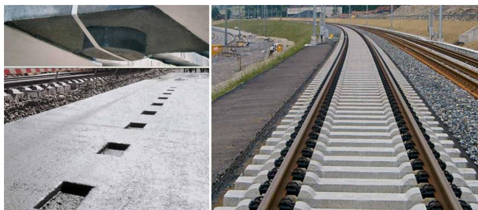
Slika 7. Sistem „GETRAC“ u Berlinu ( http://www.railone.de/fileadmin/daten/05-presse-medien/downloads/broschueren/en/Getrac_EN2012_ebook.pdf , 20.08.2021.)
