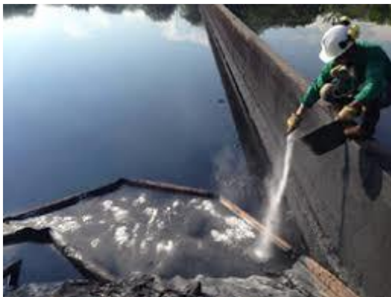
Slika 8. Nanošenje reagensa za učvršćivanje mase, [20]
