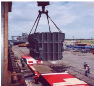
Slika 3. Transformator pri ukrcaju na brod
