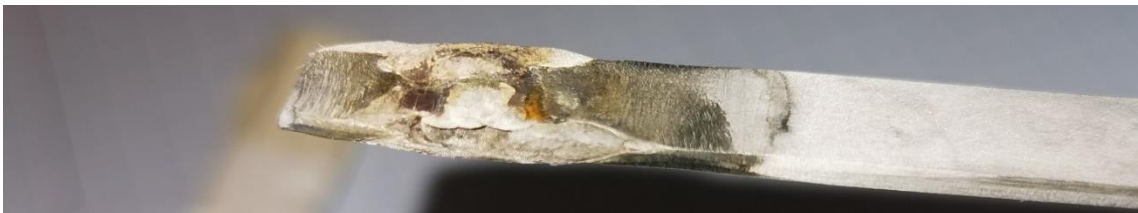
Slika 12. Korozija zavara koji nije pasiviziran
