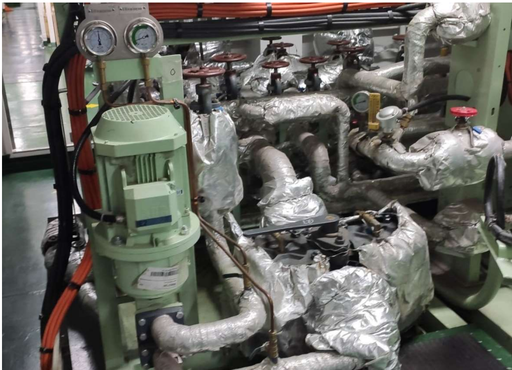
Slika 4. Prikaz napojne pumpe s usisnim filterom
