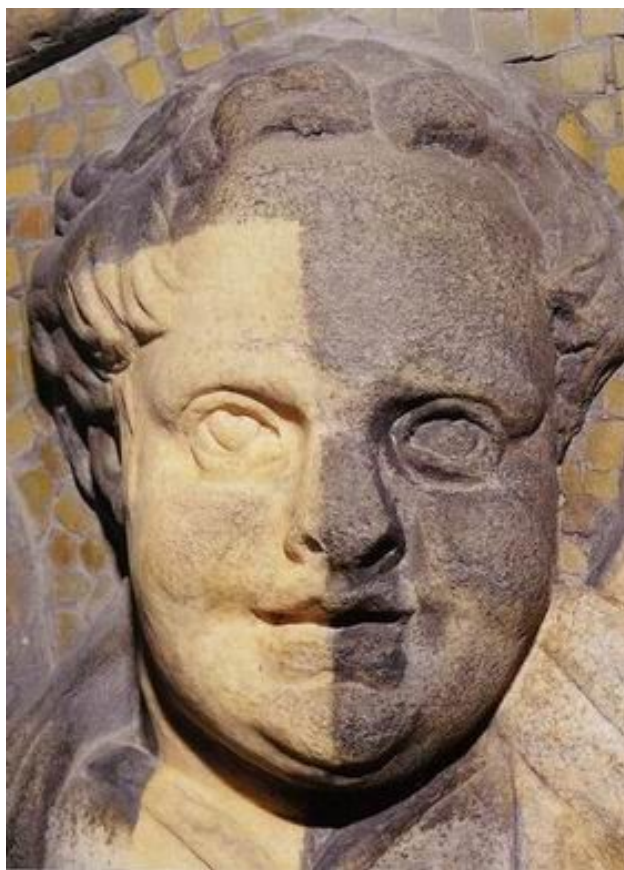
Slika 13. Primjer čišćenja kamena pomoću lasera
