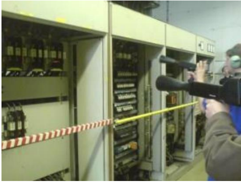
Slika 17. Ultrazvučno ispitivanje elektro ormara
