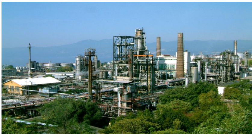
Slika 1. Rafinerija nafte Rijeka - Postrojenja Maziva – Mlaka [17]
