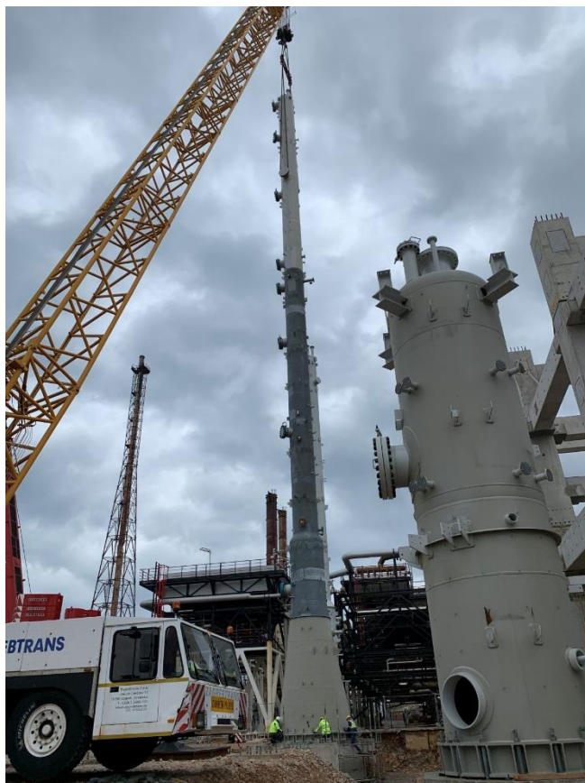
Slika 4. Postavljanje kolone teške 166 tona, visoke 55 m za novo postrojenje [21]
