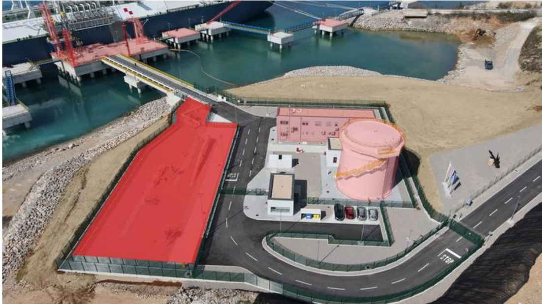
Slika 7. Kopneni dio terminala UPP
