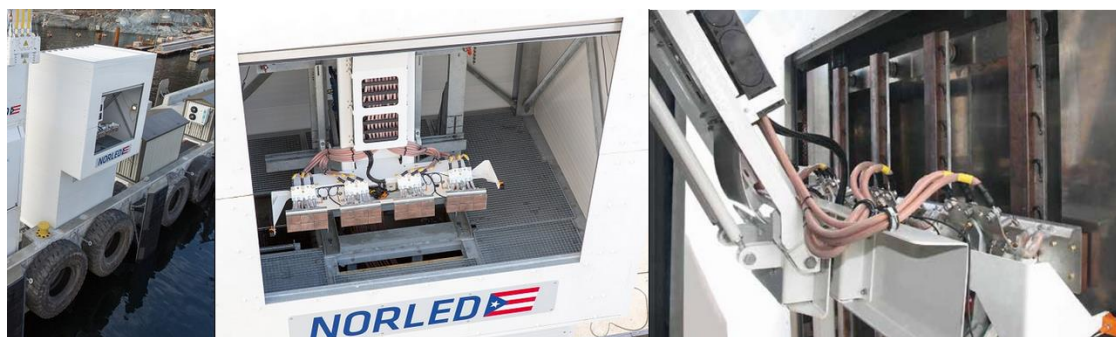
Slika 27: FerryCharger automatsko sučelje sustava kopnenog priključka na ro-ro putničkom brodu „Ampere“; Kopneni dio sučelja (lijevo); Pantograf (sredina); Spoj pantografa s brodskim dijelom sučelja (desno)
