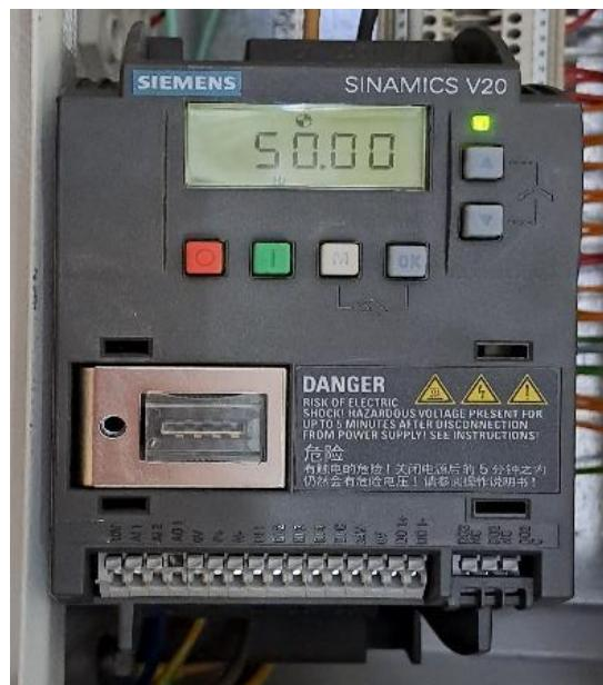
Slika 26: Vrtnja motora pri punoj frekvenciji
