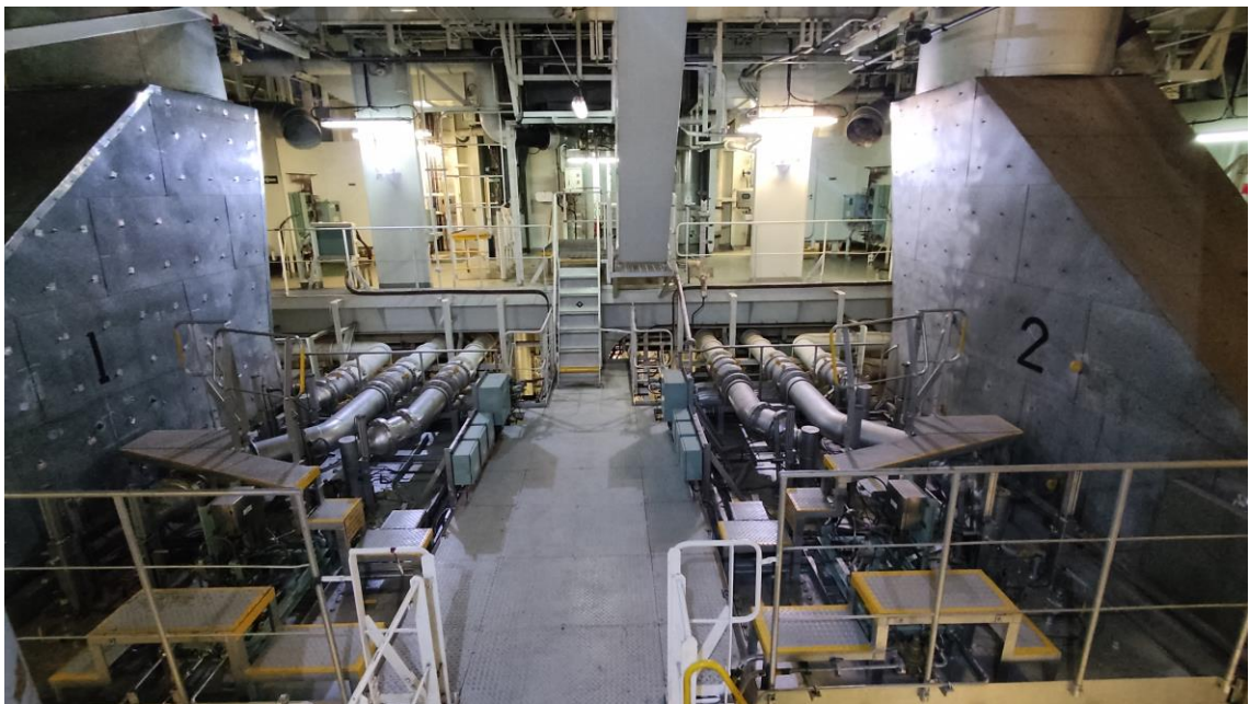
Slika 2: Prikaz oba generatora pare za ponovno uplinjavanje na brodu "Suez Neptune"[9]
