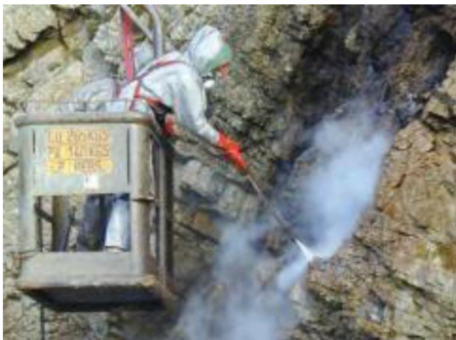
Slika 11. Prikaz korištenja visokotlačnog sustava u pranju uljne površine
