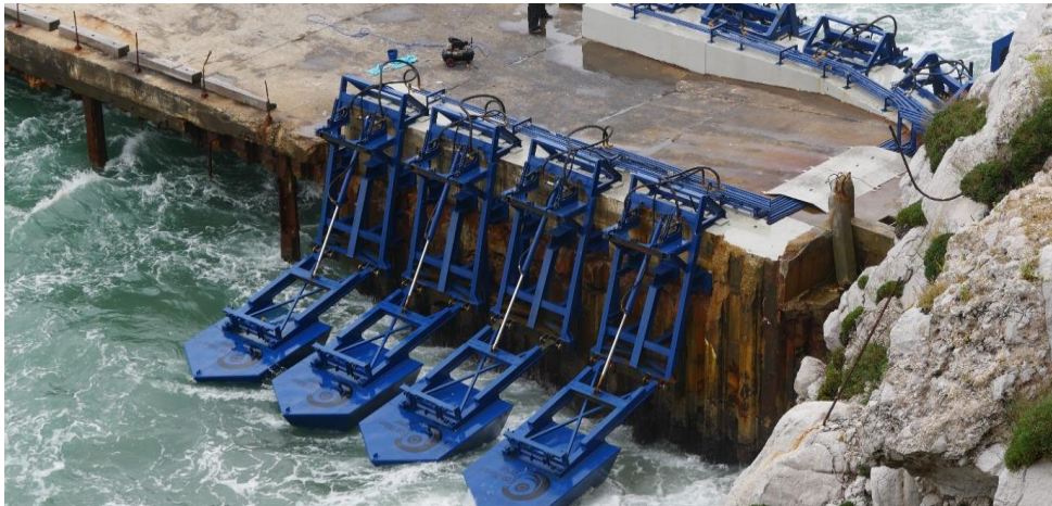
Slika 20: EcoWave Power fiksirani točkasti apsorber valova
