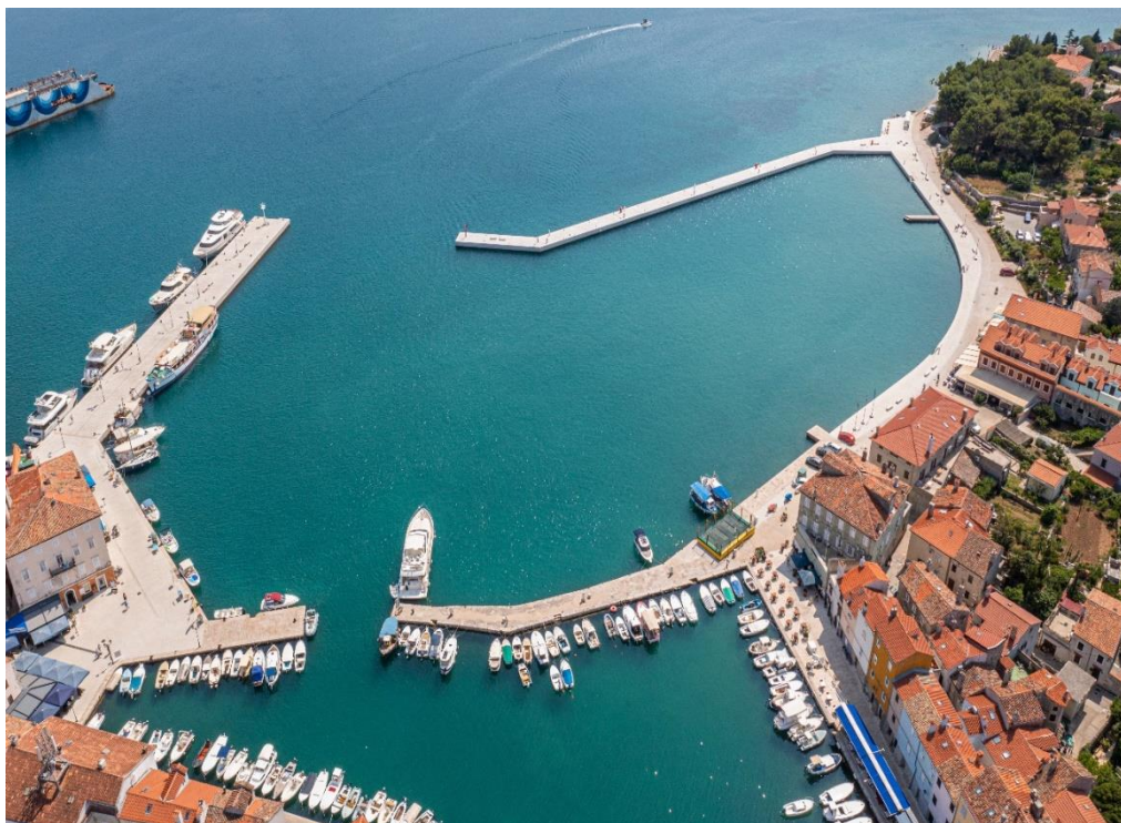
Slika 7. Luka Cres nakon rekonstrukcije
