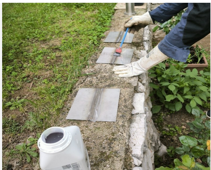
Slika 18. Kemijska zaštitna obrada pastom Avesta Izvor: Autor
