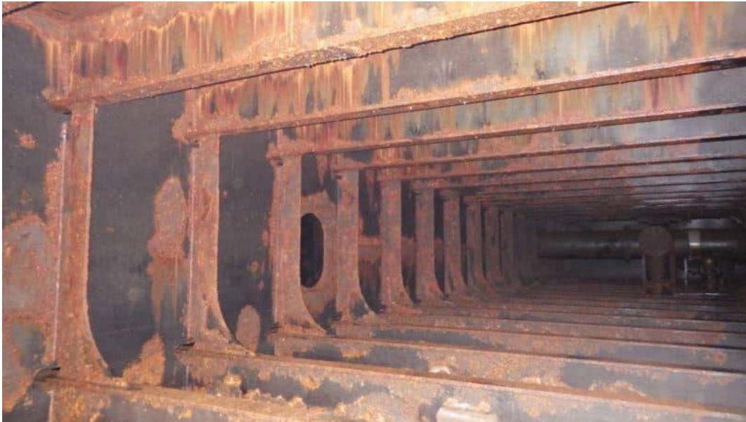
Slika 22. Tank balasta na brodu za prijevoz sirove nafte
