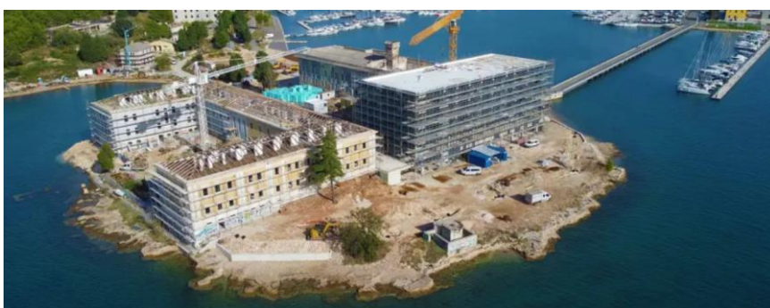
Slika 36 .Hotelski kompleks u izgradnji
