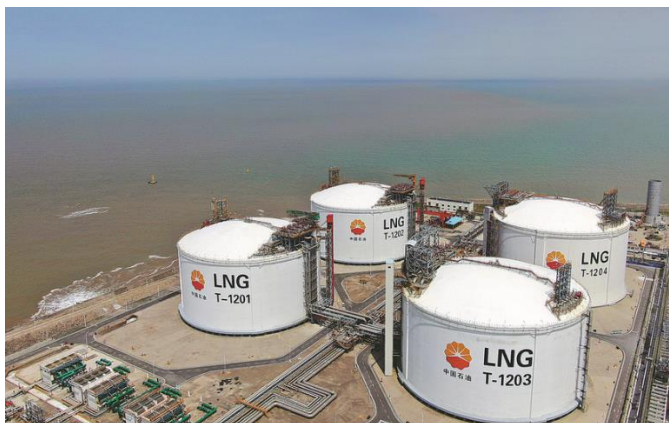
Slika 11 Prihvatni tank na LNG terminalu
