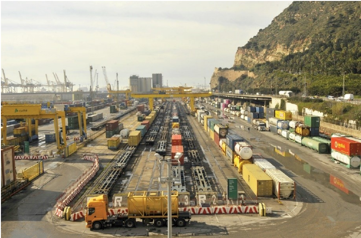
Slika 11. Željeznički terminal Morrot
